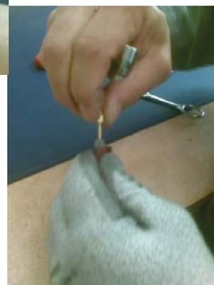
Usando una llave de tubo del 6, atornillar el extremo hasta que haga tope en el cable.
