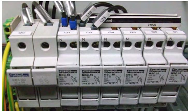
El portafusible F1 está instalado del lado del automático:
